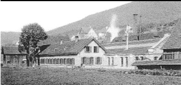
Werk Friedrichstal, Sensenhammer von Westen, 1899/1900
