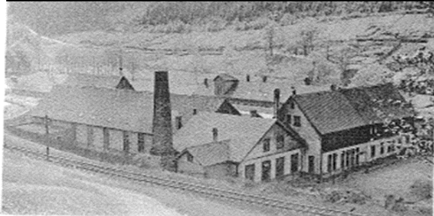
Werk Friedrichstal, Blick auf den Sensenhammer von der Freudenstädter Straße aus, 1936
