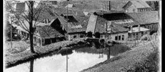
Die die älteste Werkhalle, die "Hauenschmiede", ist heute noch in Betrieb. Früher wurden darin vor allem Hauen und Spaten hergestellt. Heute fertigt man darin auch noch andere Werkzeuge für die Landwirtschaft.
